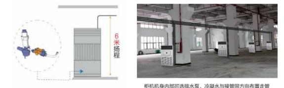
柜机机身内部可选排水泵，冷凝水与接管同方向布置走管
